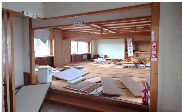
和室 入口の鴨居の外れ。襖・障子・座卓散乱 他
