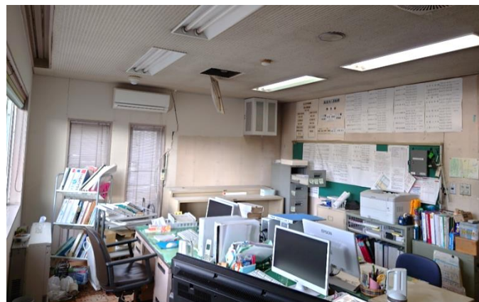
事務室 室内の壁が全面浮いた状態。書棚落下 他
