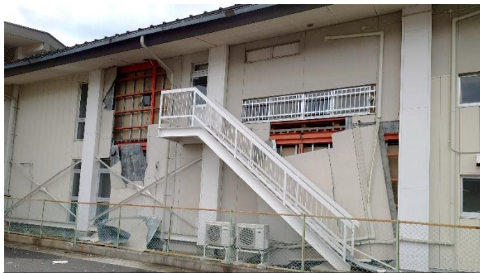
屋外(北側)外壁崩落・筋交い湾曲・ガス管断絶 他
