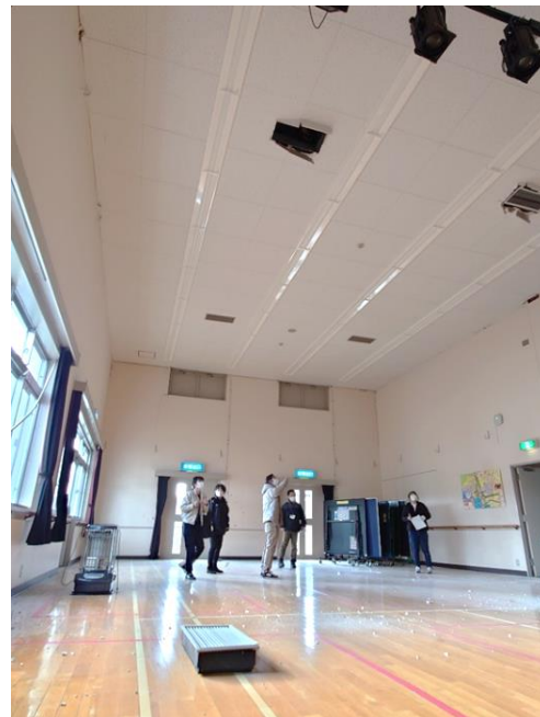
ホール 筋交い湾曲・換気扇落下 壁崩壊/亀裂多数 他
